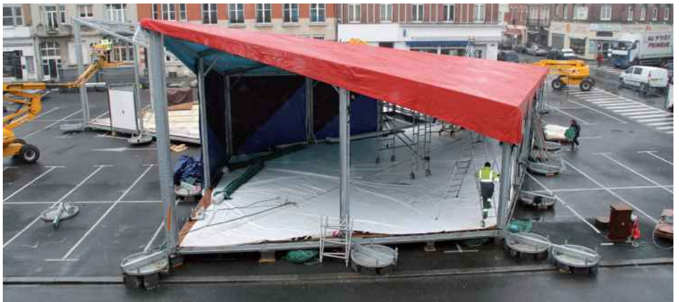
Montage de la structure du Centre Pompidou mobile © Ville de Cambrai
