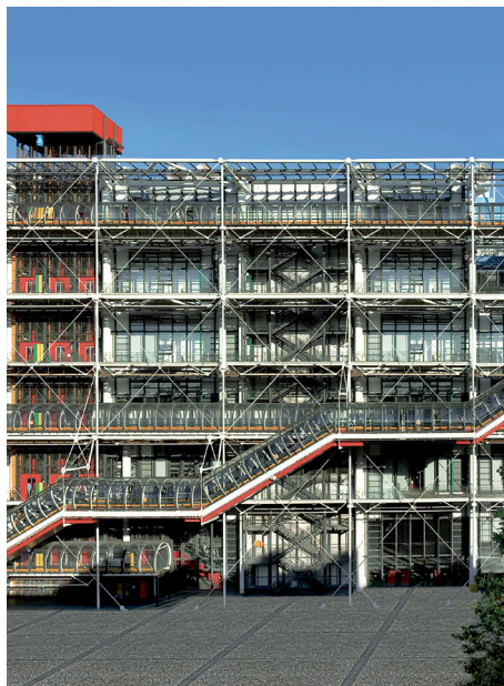
Centre Pompidou Architectes : Renzo Piano et Richard Rogers, photo : G. Meguerditchian © Centre Pompidou, 2019
